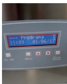
Detalle Panel Mandos BV
