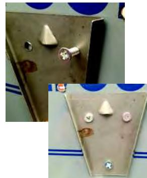
Fije la chapa triangular trasera del dosificador de jabón con sus tornillos en el peto postizo a la pared en los tacos previamente fijados
