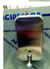
Coloque el dosificador de jabón en la chapa triangular. Apriete el tornillo del dosificador de jabón hasta que éste quede firme
