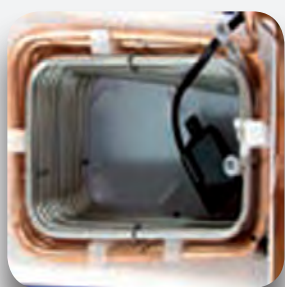
Sistema refrigeración banco de hielo.
