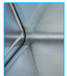
Cantos internos redondeados para facilitar limpieza
