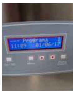
Detalle Panel Mandos BV
